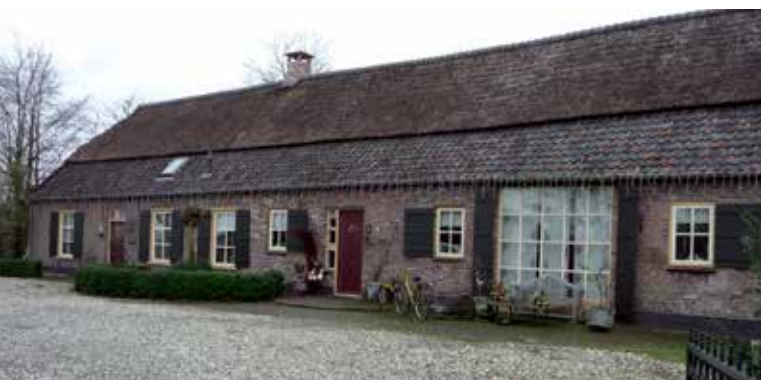
De boerderij van Jos Sengers gebouwd rond 1860 op de fundamenteën van de Schoteldonkse Hoeve [foto: Roland van Pareren, januari 2017]
