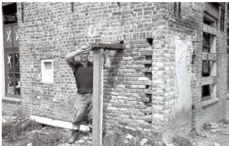
Metselaar Frans Dekkers herstelt de havende hoek
