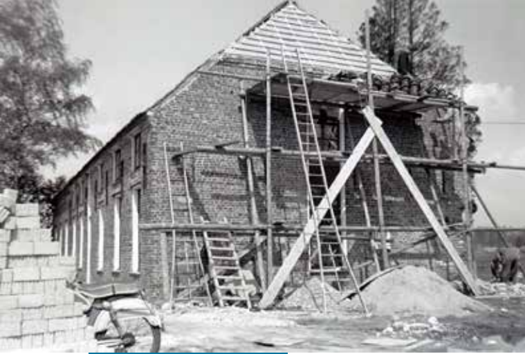
De restauratie van het dak
