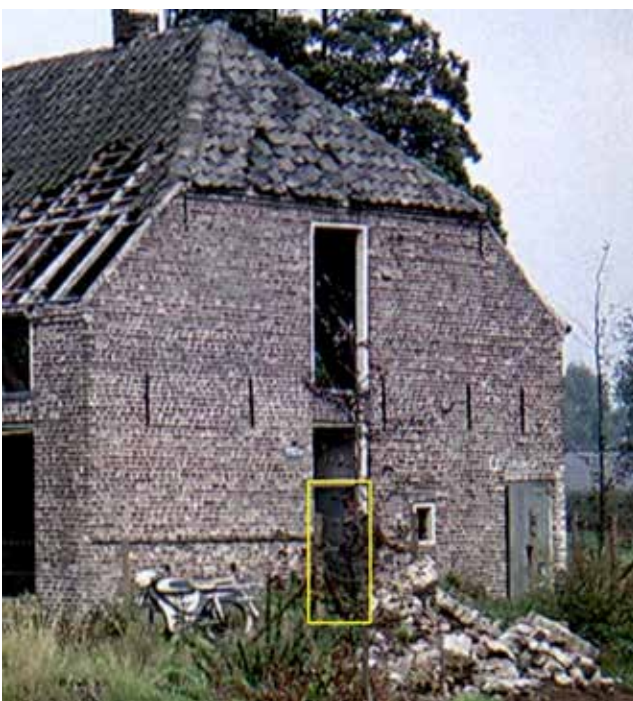
De zuidelijke kopgevel vóór de restauratie met in het midden de originele ingang
